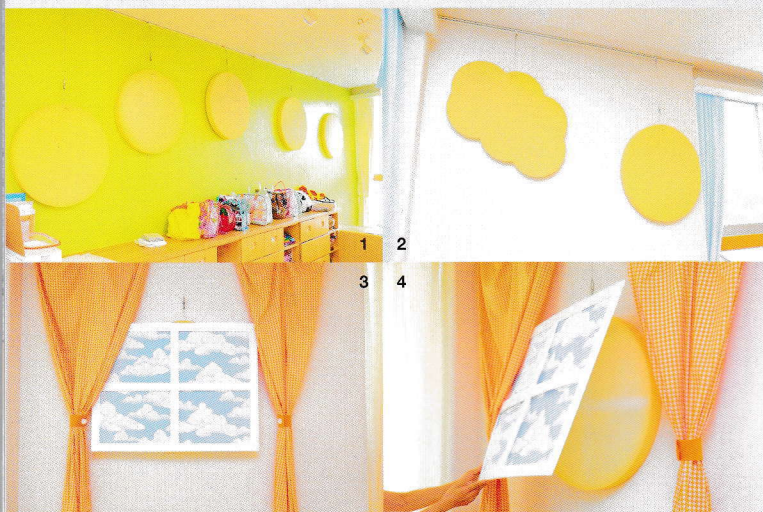
1.2. 丸い形や、雲のような形に切り取られたスポンジのような吸音材。壁にオブジェのように吊るされています。3.4. かわいらしい窓の奥には…吸音材が隠れていました。「とても上手にやっていただいて。気に入っています」(園長先生)
