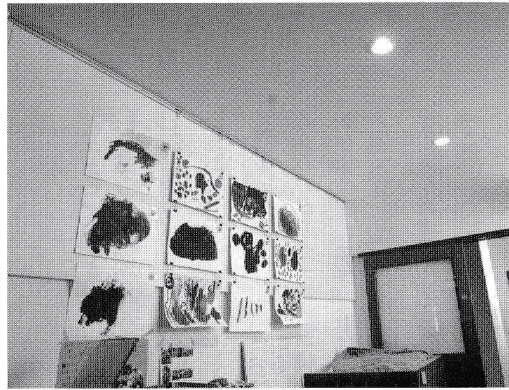
壁と絵の間に貼られているのが吸音材。本当は天井に貼るのが効果的だが、照明をつけ直さないと貼れないので断念した。
